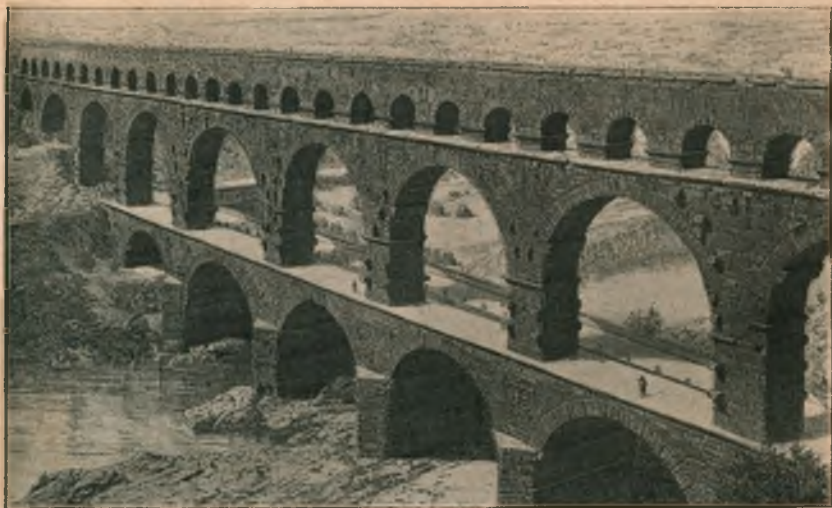
Most i wodociąg w Nîmes (Francya południowa).
