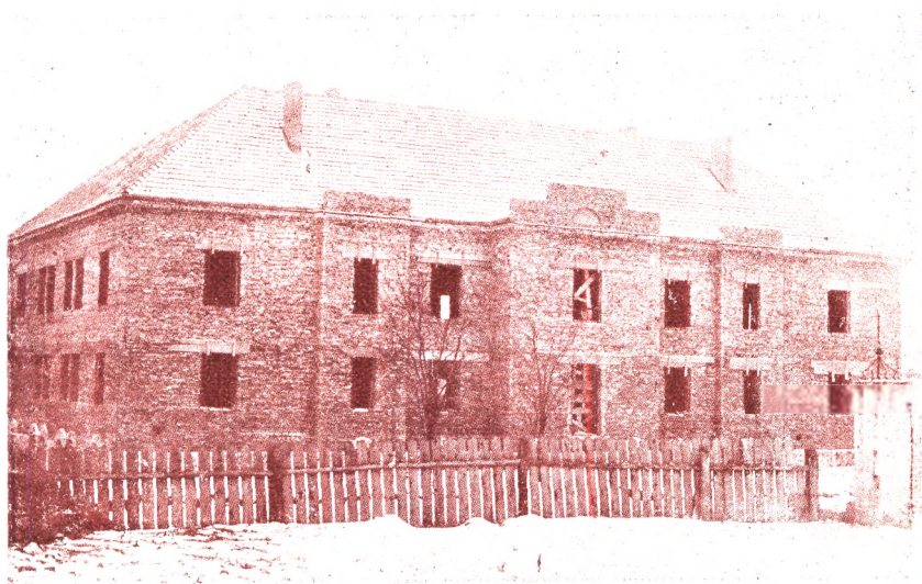
WIDOK BUDUJĄCEJ SIĘ BURSY GIMNAZJALNEJ.
