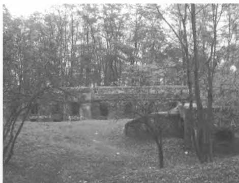
Fort 48a Mistrzejowice w stanie zdewastowanym
