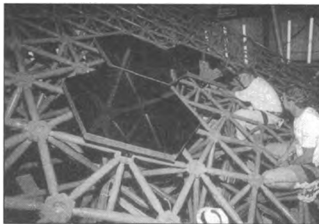
Montaż elementów zwierciadła głównego w teleskopie HET
