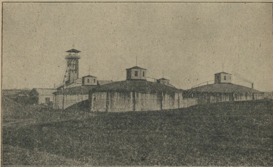
rys. 101. Wieliczka. Główne zbiorniki solanki u szybu „Kościuszki“.
