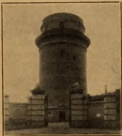
18. Wieża ciśnień wodociągów miejskich w Radomiu
