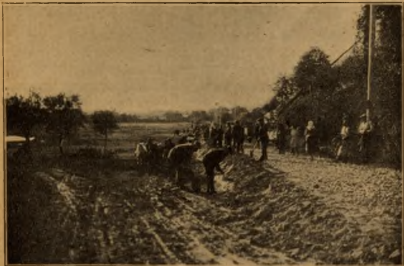
32. Budowa drogi w Sokolnikach, powiat Lwowski, rozpoczęta w dniu Święta pracy
