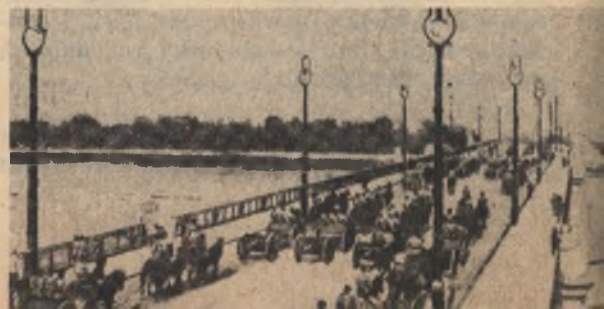
Próba mostu pod ciężarem armat
