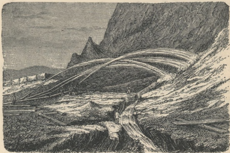
Ryc. 149. Rozbijanie skał złotonośnych strumieniami wody.
